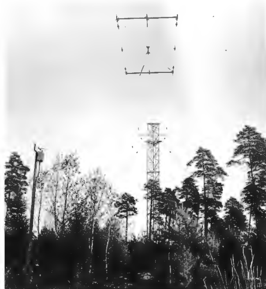
Logperiodisk riktantenn 4 – 30 MHz (vid sändarannex)
