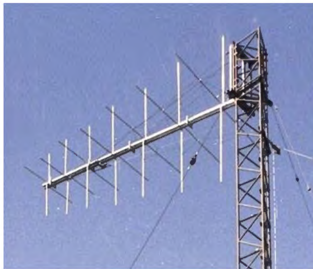
Krysslogantenn 25 – 30 MHz 10 kW
