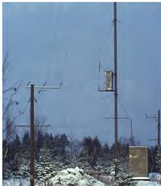
Deltaantenn 2 – 10 MHz 10 kW
