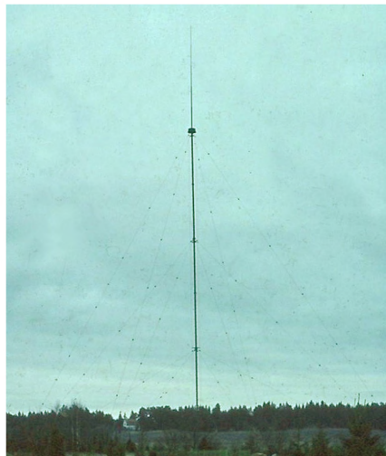
Vertikalantenn 2 – 12 MHz 10 kW
