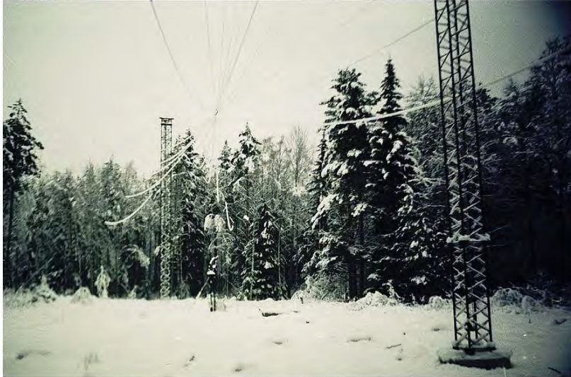
Scheuerecker dipolantenn 2 – 12 MHz 10 kW
