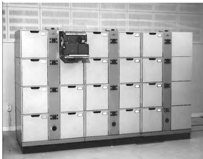
LVA 2 Övervakningsplats freds Hs. LVA 2 Stativ för kontrollmaskiner före utbyggnad till 30 linjer
